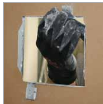
8 Fastgørelsesbeslag bøjes så de fastholder rammen. Enden på beslag bøjes ind mod bagsiden af gipsen, så beslaget ligger dobbelt, hvorefter beslaget bøjes så det klemmer mod gipsen.
