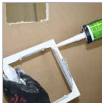
6 For bedre vedhæftning fuges med Gyproc G55 eller lignende langs rammens kant.
