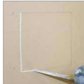
4 Sav efter markeringen. Hvis du har valgt at måle efter rammens indermål, skal du save på udvendig side af stregen.
