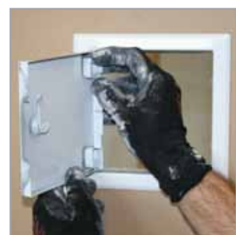
9 Sæt nu lugen tilbage på samme måde som den blev fjernet. Det kan frit vælges om lugen skal være venstre- eller højrehængt. Aftør evt. overskydende fugemasse.
