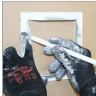
3 Opmål lugens placering på væggen. Hulmål skal være som lugens nominelle mål, f.eks. 300 x 300 mm. Tip: vend rammen og opmål placering ved markering med blyant efter rammens indermål.
