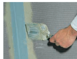
Til sidst indsættes fugebånd, der spartles med vægspartelmassen – færdig er det glatte underlag!
