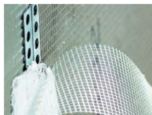
Med glasvævsstrimlerne lukkes pladestødene.
