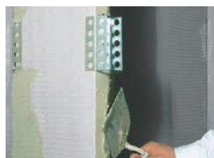
Også Murexin forbindelsesbeslaget er hurtigt monteret.
