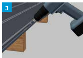
3 Sidste række planker fastgøres med start/slut clips eller med skruer på skrå (husk; bor for) ind i noten.
