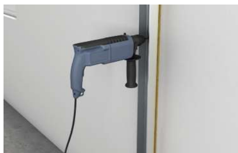
Fastgørelse af C-profiler på væggene med en lydisolerende filt- eller mineraluldsstrimmel.
