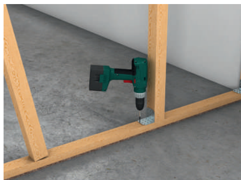
Montage af underkonstruktion i træ.
