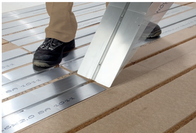
Figur 9 Varmefordelingsplader kan lægges stående.
