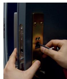
**5.** Spænd derefter inderdelen med de 3 korte medfølgende maskinskruer. 1 under håndtaget (den længste af dem) og de 2 korte gennem batteriholderen på hver side øverst. Indsæt 3 AA 1,5V batterier, husk at vend "+" og "-" korrekt. Sæt derefter batteridækslet på.
