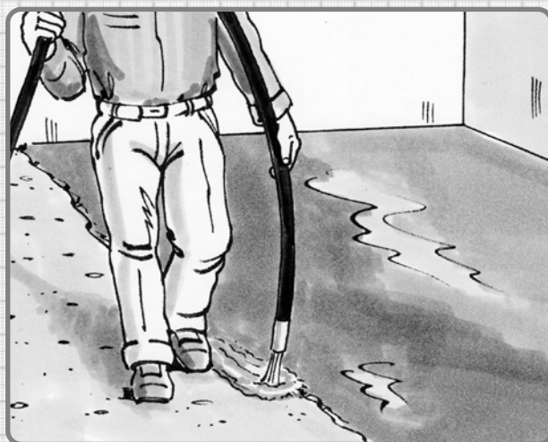
Udlægning med snækkepumpe
