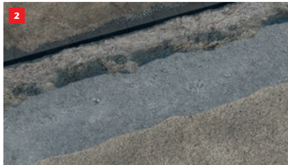
Betonklaplag/fundament udlægges.
