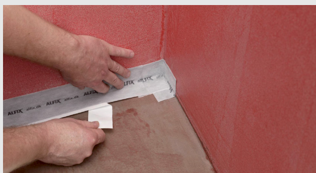
Montering i overgang væg og gulv
