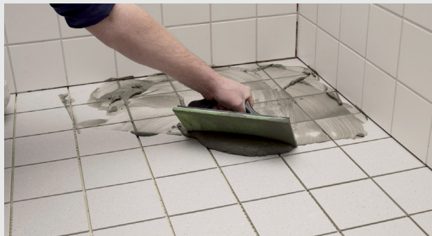
Påføring af cementbaseret fugemasse
