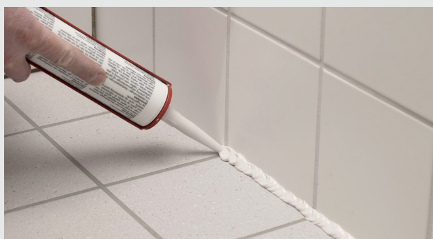
Fyldning med siliconebaseret fugemasse
