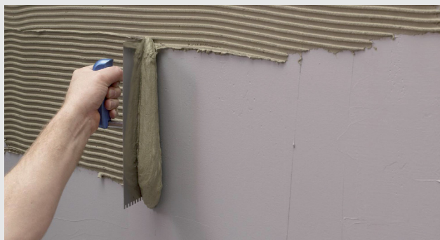
Påføring af fliseklæber
