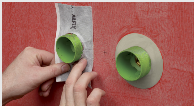
Montering ved rør
