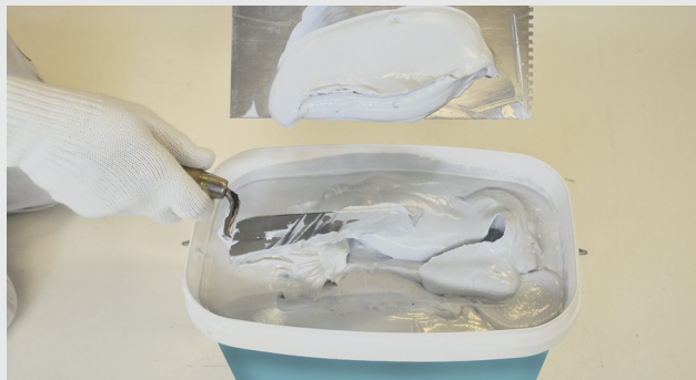
Tætningsmasse klar til påføring
