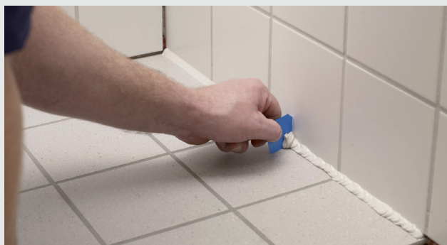
Overskydende fugemasse fjernes
