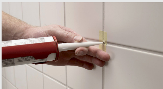
Fyldning af hullet med silikone
