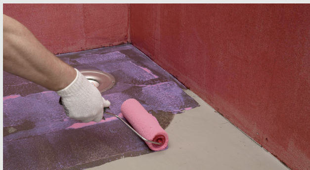
Primning på gulv med rulle
