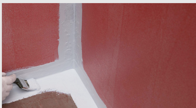
Påføring med pensel
