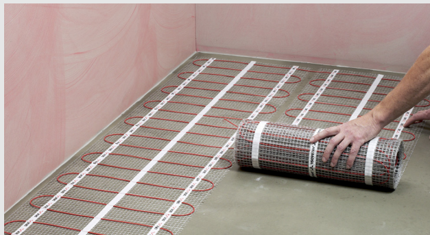
Udlægning af varmemåtter
