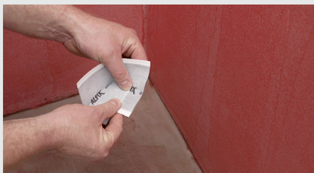
Tilpasning af selvklæbende hjørne
