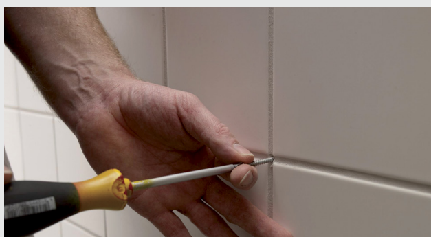
Montering af skrue efter fyldning med silikone
