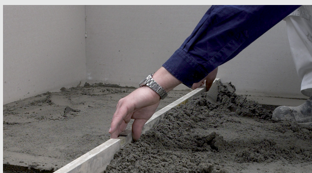
Udstøbning på træbjælkelag
