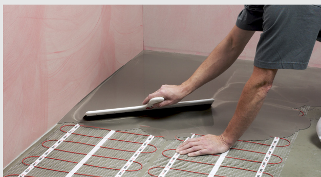
Fordeling af spartelmasse
