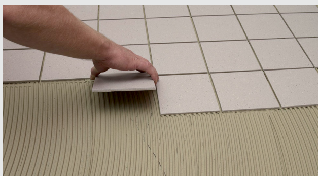
Montering på gulv
