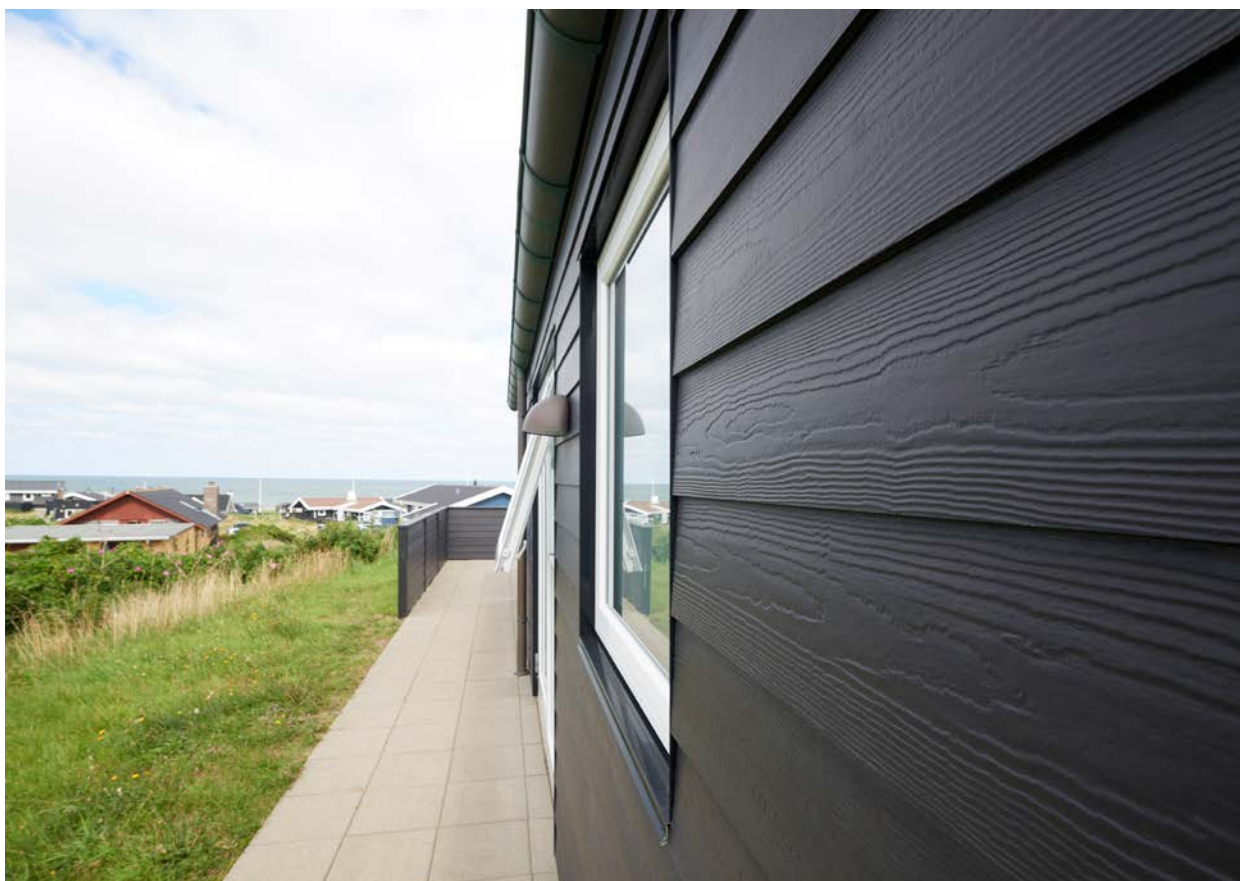
Hardie® Plank, vandret klinkmontage. Farve: Sort
