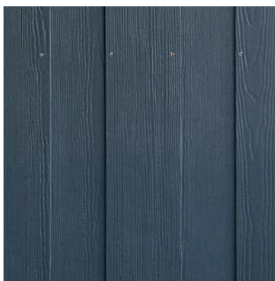
Hardie® Plank monteret efter 1 på 2 metoden
