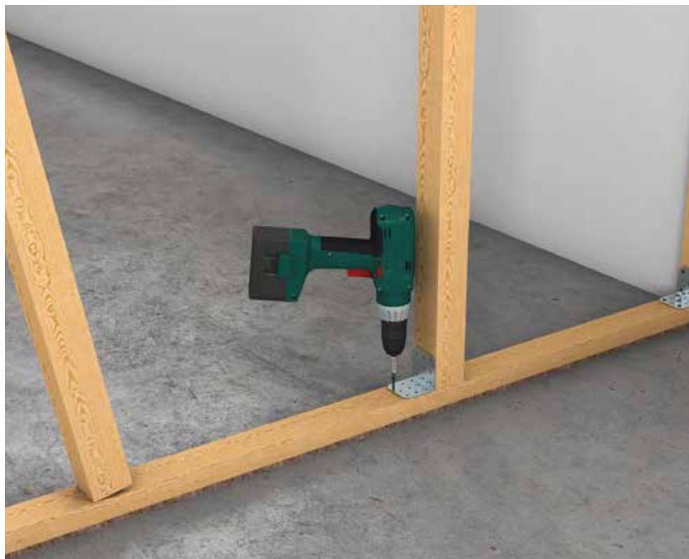
Montage af underkonstruktion i træ.
