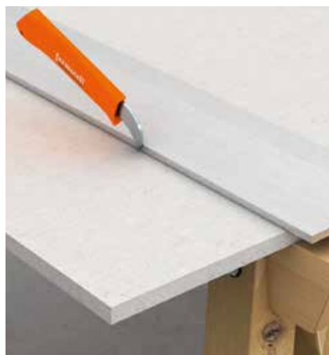
Step 1 - Ridsning og knækning.
