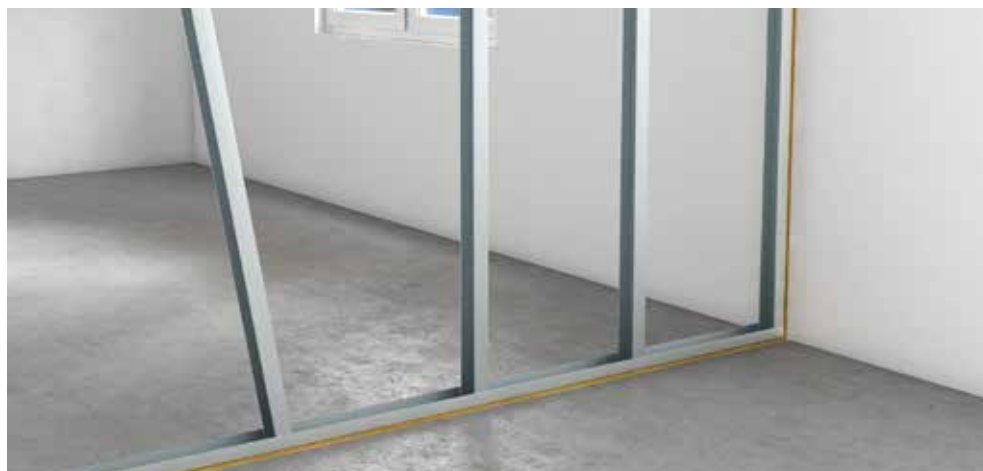
Montage af CW-stålprofiler.
