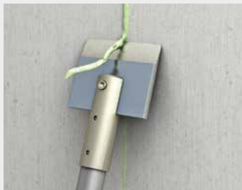
Fjern overskydende klæbefuge efter cirka 24 timer.
