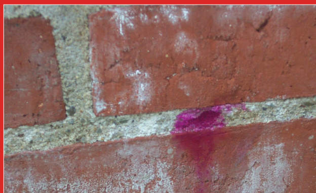
For tidlig vandpåvirkning af vægflade: Hvidlige udfældninger og begyndende frostafskalninger i mørtelfuger.
