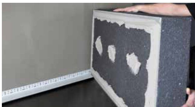
Montering af isoleringsplade
