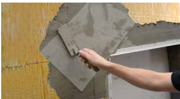
Montering af armeringsnet ved vinduesfals
