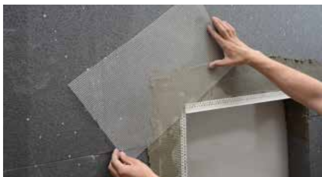
Tilpasning af armeringsnet ved vinduesfåse
