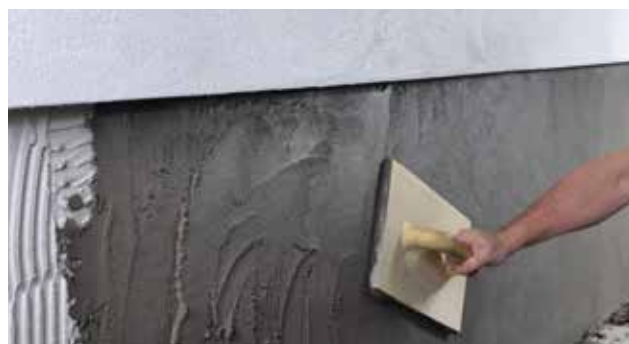
Pudsning af sokkel med pudsebræt
