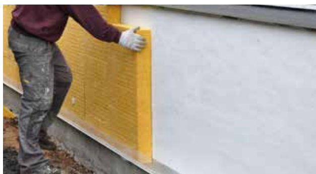
Montering af mineraluldplader min. 15 cm over terræn
