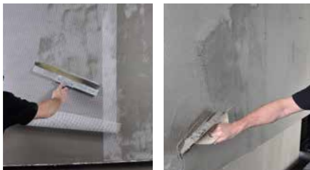
Montering af net med min. 10 cm overlap og påføring af heldækkende lag Alfix DuraPuds 810
