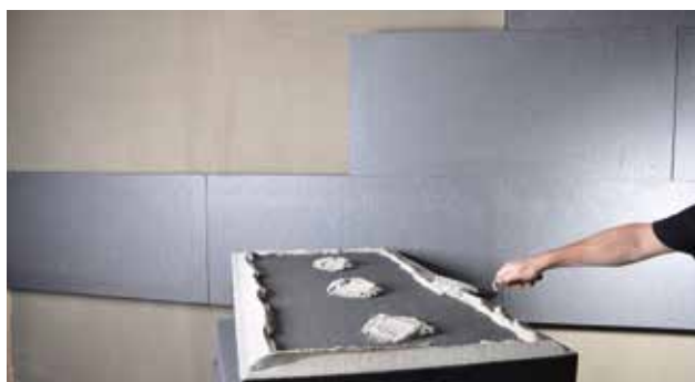
Påføring af Alfix DuraPuds 830 med reparationssske
