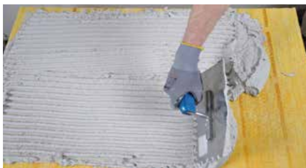
Påføring af Alfix DuraPuds 830 med tandspartel
