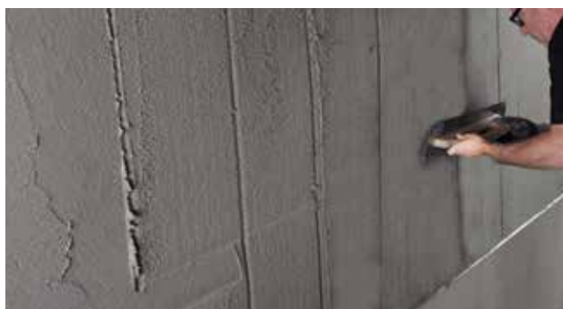
Påføring af Alfix DuraPuds 810 med stålbret med afstandstænder
