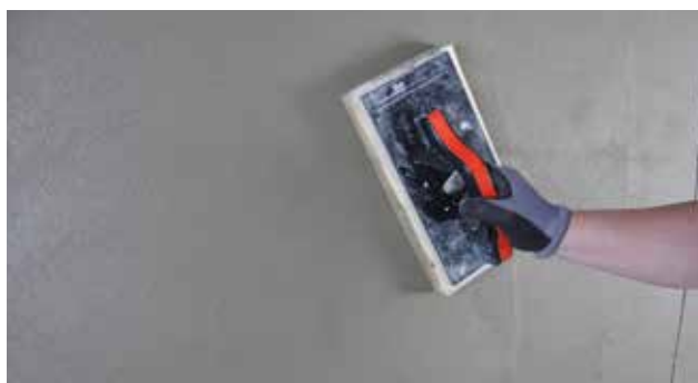
Filtsning af overfladen
