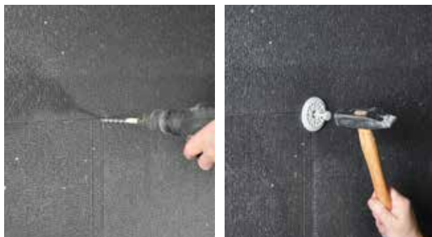
Montering af termodybel
