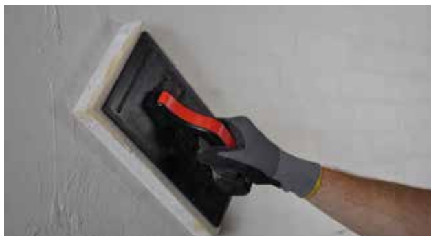
Filtsning af overfladen
