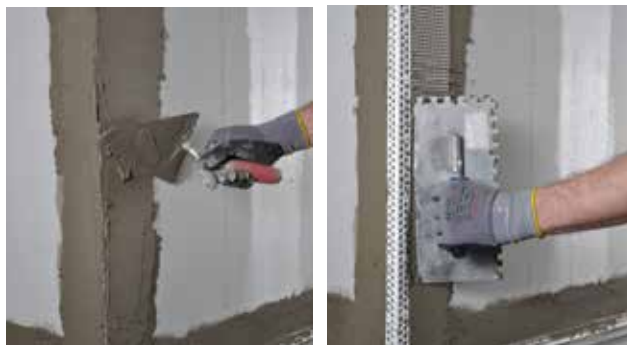
Montering af hjørne- og bundlister
