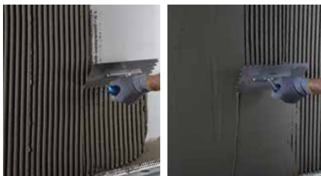
Påføring af Alfix DuraPuds 710 / 810 med tandspartel
