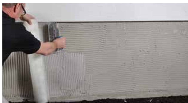
Montering af armeringsnet i Alfix DuraPuds 615
