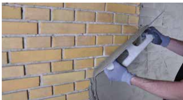
Påføring af kontaktag med DuraPuds 710
