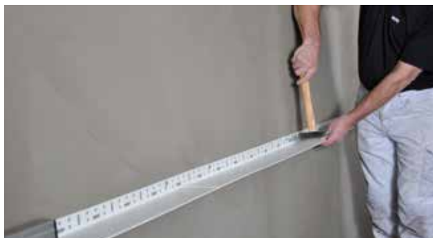
Montering af Alfix Startvinkel Flex
