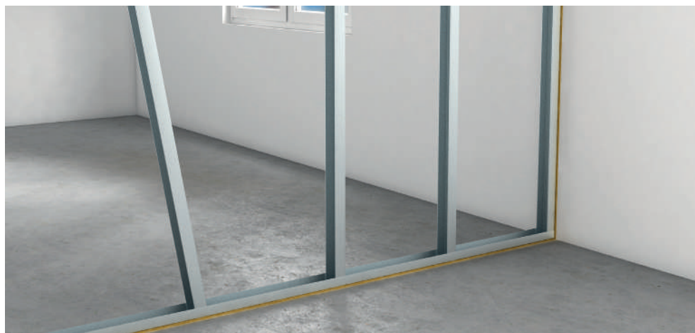
Montage af CW-stålprofiler.
