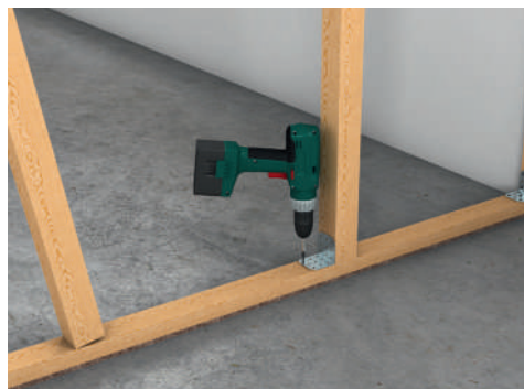
Montage af underkonstruktion i træ.
