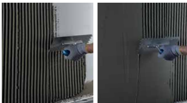
Påføring af Alfix DuraPuds 710 / 810 med tandspartel
