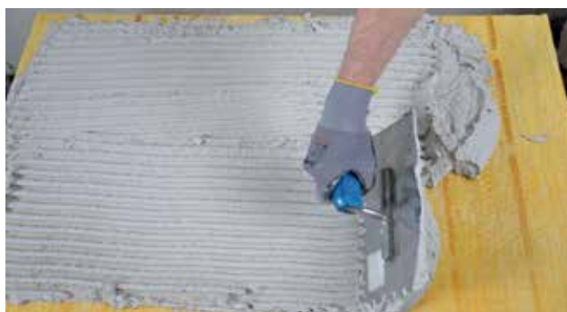
Påføring af Alfix DuraPuds 830 med tandspartel
