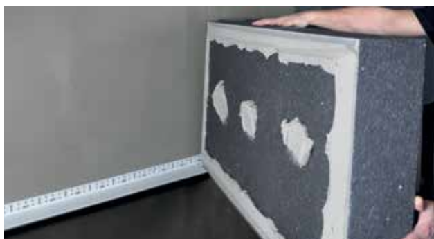
Montering af isoleringsplade
