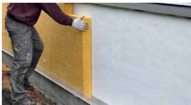
Montering af mineraluldplader min. 15 cm over terræn
