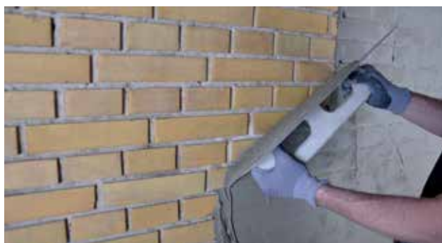
Påføring af kontaktlag med DuraPuds 710
