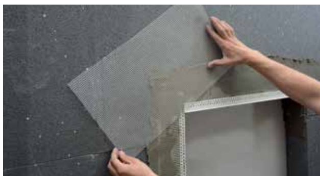
Tilpasning af armeringsnet ved vinduesfåse
