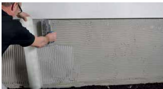
Montering af armeringsnet i Alfix DuraPuds 615
