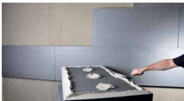
Påføring af Alfix DuraPuds 830 med reparationsske
