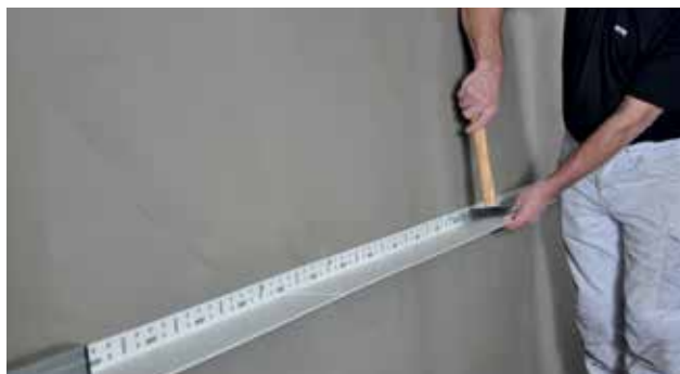
Montering af Alfix Startvinkel Flex
