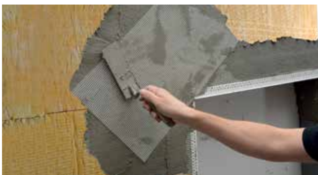
Montering af armeringsnet ved vinduesfals
