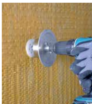
Montering af dybler og isætning af rondel
