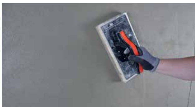
Filtsning af overfladen
