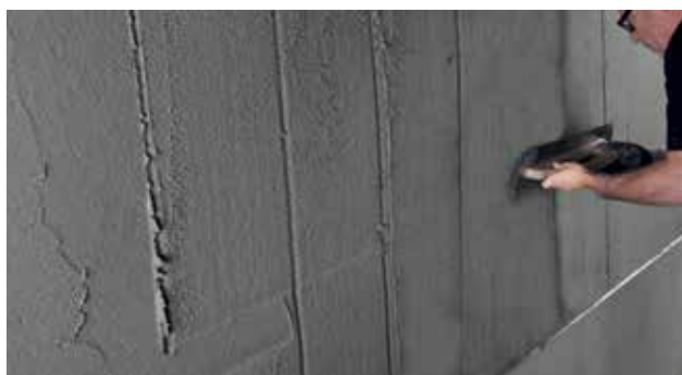
Påføring af Alfix DuraPuds 810 med stålblæt med afstandstænder
