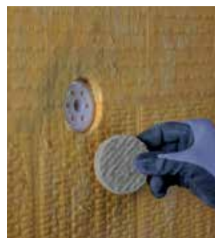
Montering af dybler og isætning af rondel
