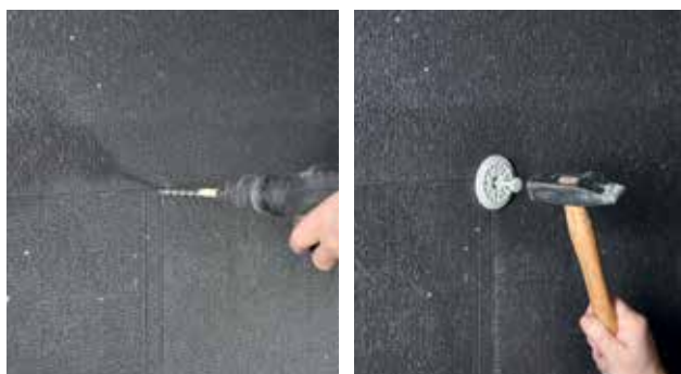
Montering af termodybel
