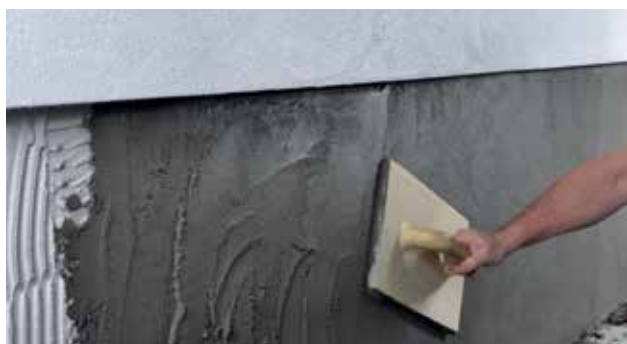
Pudsning af sokkel med pudsebræt
