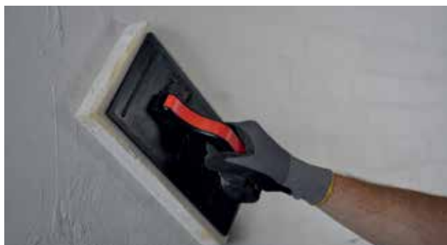
Filtsning af overfladen
