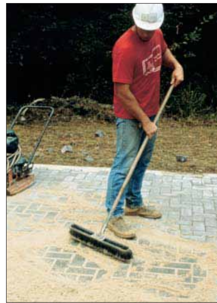
Fugegrus fejes i fugerne inden første vibrering.
