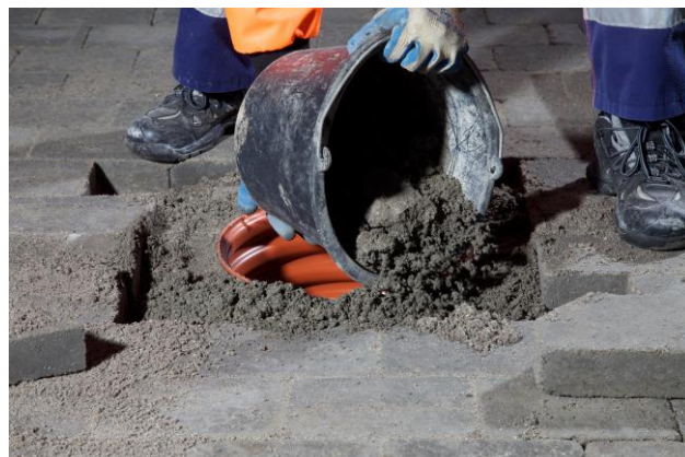
Beton dæksel og belægningsstenene fjernes. Der lægges beton rundt om opføringsrøret.
