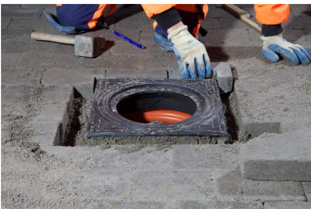
Stenene skæres til og lægges i grus
