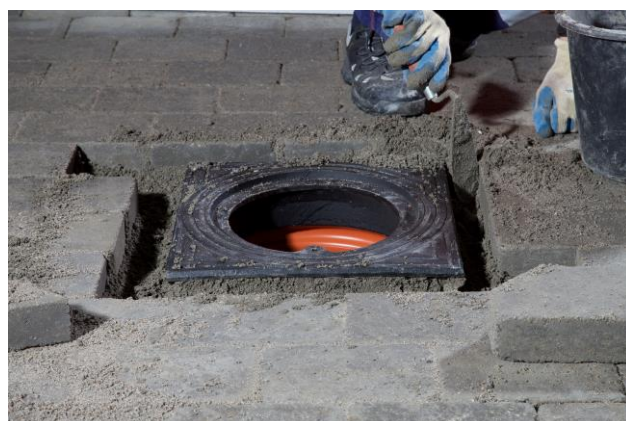
Den overskydende beton fjernes.
