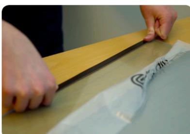
**5** Fjern herefter 10-15 cm af beskyttelsesfolien langs forsatsrudens kant. Monter det sorte magnetbånd langs kanten og tryk den godt fast. Herefter fjernes folien på begge sider af forsatsruden, og ruden er klar til opsætning.
