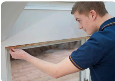
**2** Tag mål til forsatsruden, der hvor den skal sættes op. Beregn 15 mm til forsatsrudens opsætningsbånd hele vejen rundt. Forsatsruder leveres fra forhandler på udskåret mål.
