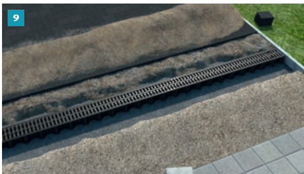
9 Ved samlet drænlængde på over 5 m, kan elementerne klikkes sammen en ad gangen. Start med udløbsselementet.
