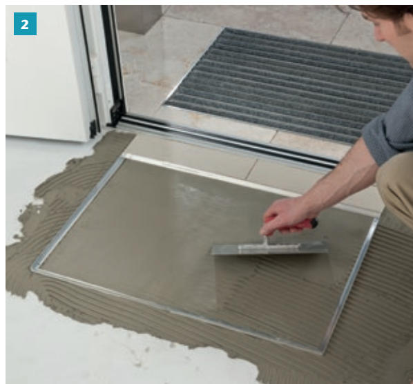
2 For at skabe en plan overflade til måtten tilrettes fliseklæben indvendigt i rammen.
