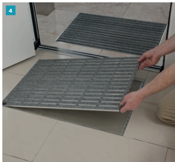
4 Når fliseklæben er tør placeres dørmåtten i rammen.
