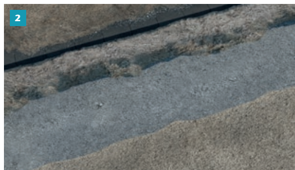
2 Betonklaplag/fundament udlægges.
