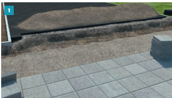
1 Fastlæg placering af linjedræn. Overvej placering af udløb. Grav en kanal – ca. 15 cm bred og 15-20 cm dyb.
