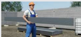
Facadebrædderne skal altid bæres på højkant.
