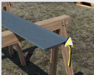
Påføring af HardieSeal™ kantforsegling før monteringen.
