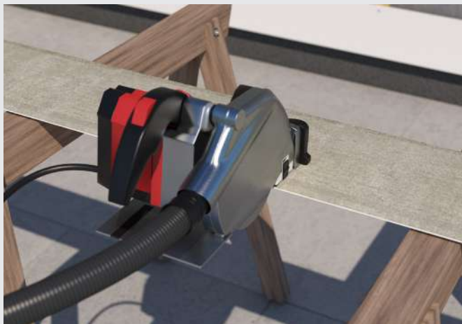
Anvend et savblad, der er egnet til at skære i fibercement (anbefaling: HardieBlade®).
