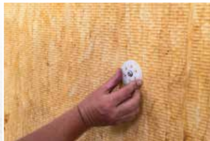
Termodyvlen isættes plan med isoleringensoverfladen.
