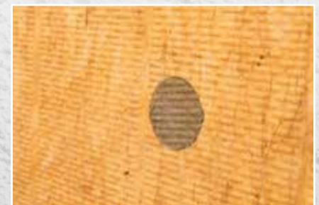
Isoleringsoverfladen er nu klar til grundpuds.
