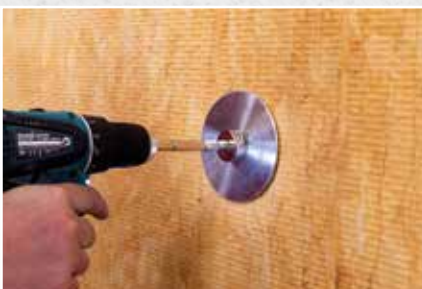
Når værktøjets krave er plan med isoleringen er dyvelmontagen færdig.
