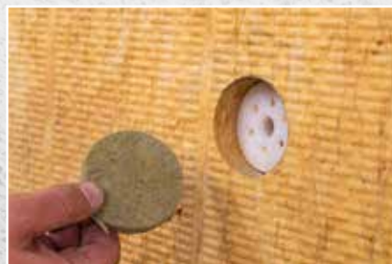
Passende isoleringsrondel monteres.
