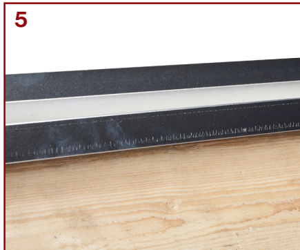
Beklædning monteres nu ovenpå facadeprofil.
