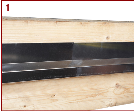
Facadeprofil monteres fra højre mod venstre.
