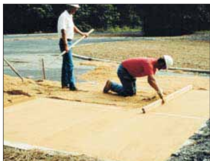
Afretningen kan foretages med et lige bræt og ledeskinner i form af jernrør, der lægges i afretningslaget.
