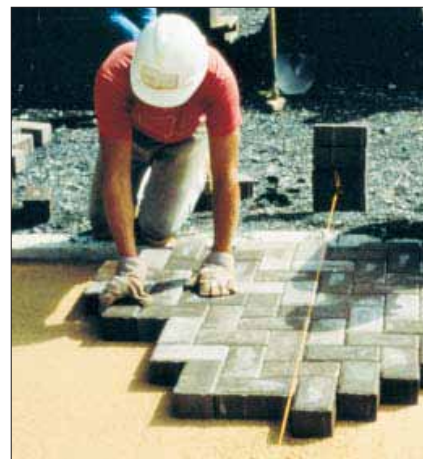
Udspændning af snore gør det let at opretholde flugterne.
