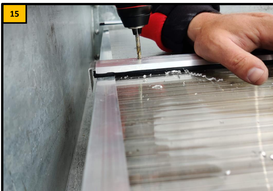
15. stopbeslag (nr. 13) monteres. Stopbeslag skubbes op i aluprofilet og fastgøres gennem aluprofil og stopbeslag med skrue (nr. 16) med 5 mm luft mellem stopbeslag og drynæseprofil. NB. Spåner efter boring fjernes fra taget
