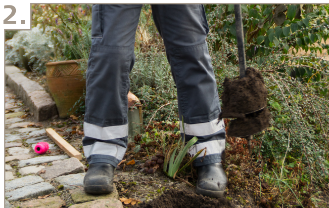
2. Start med at finde ud af, hvor den første stolpe skal være. Herefter borer eller graver du det første hul. Det skal være 80 til 90 cm dybt, for at stolpen står stabilt. Sørg for at stolpen står i vater, mens der fyldes jord i hullet og stemples omkring stolpen (om nødvendigt støbes i beton).
