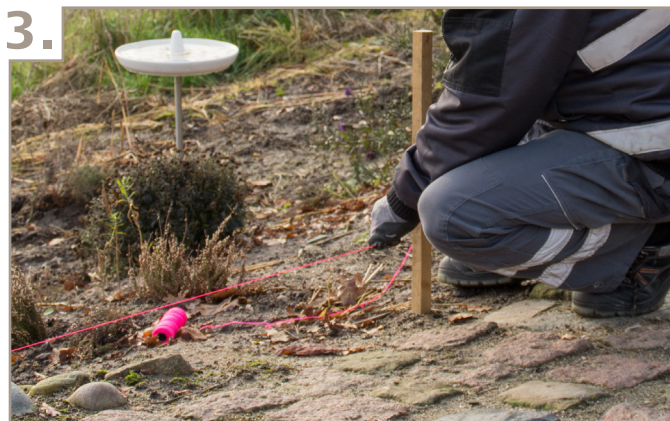
3. Når den første stolpe er sat, placeres en pind i flugt med hegnet. Der bindes en snor fra første stolpe hen til pinden for at sikre, at stolperne sættes på en lige række.
