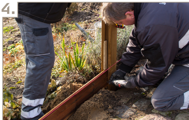
4. Herefter skal du sætte den næste stolpe. Brug en hegnsprofil til at finde den rigtige afstand. Bor et nyt hul og placer stolpen på samme måde som ved punkt 2. Monter herefter en profil foroven og forneden med en midlertidig skrue.
