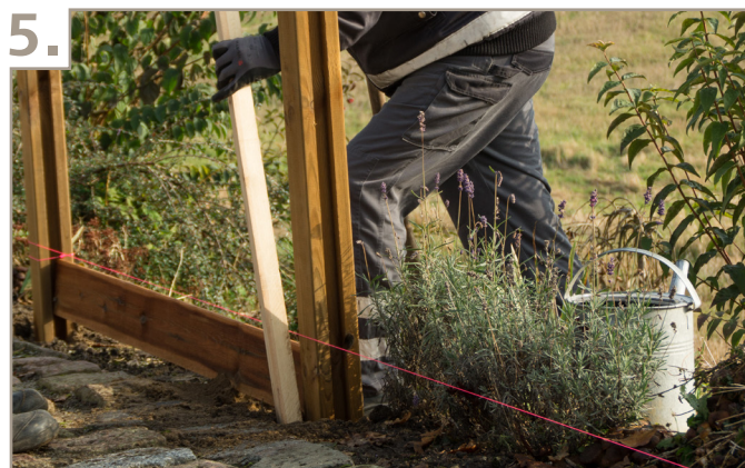
5. Nu har du styr på afstanden fra første til anden stolpe, og nu skal jorden omkring den også stemples fast. Husk hele tiden at holde øje med vaterpasset, så stolpen kommer til at stå i lod.
