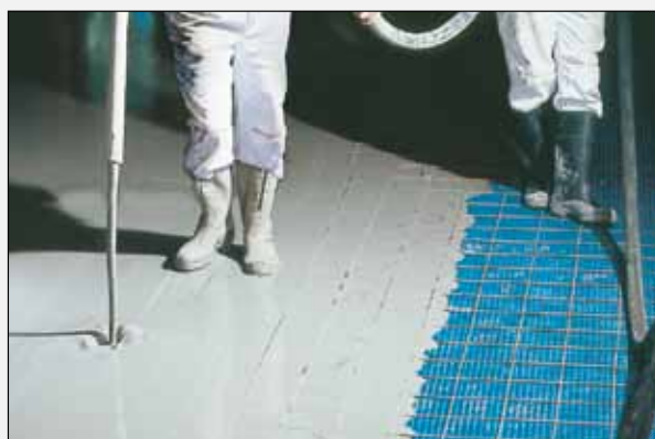
Platon Multi Til trægulve op til 12 mm og til gulve med afretningsmasse eller beton
