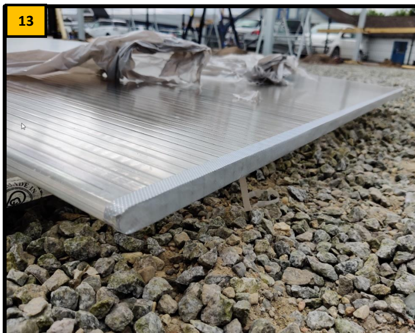
13. Montering af termoplader. Inden montering af termopladerne lukkes begge ender med diffusionsåben tape.
