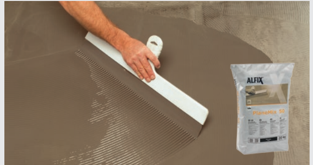
Fordeling af spartelmasse
