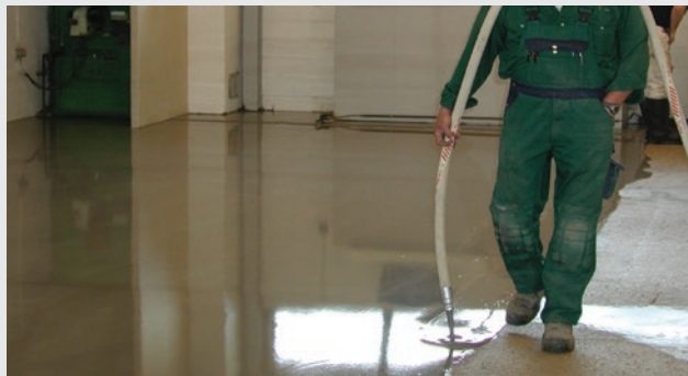
Udlægning med spartelpumpe
