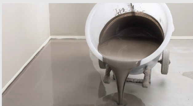
Udhældning af spartelmasse
