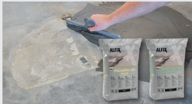
Revner og lunger udbedres
