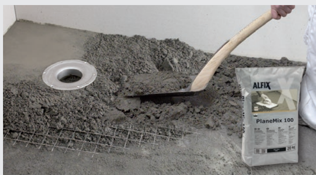
Opbygning af fald med støbemasse
