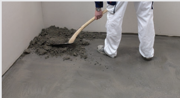
Støbemasse fordeles jævnt
