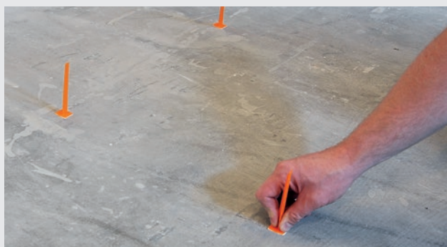
Markering med kotemål
