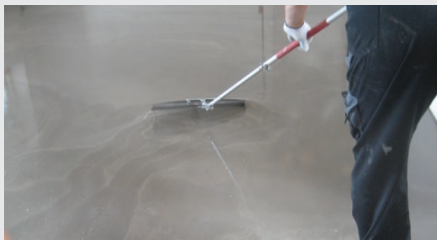
Fordeling af spartelmassen
