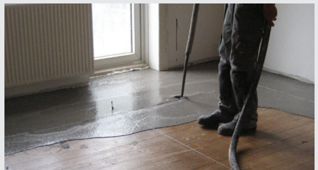
Spartling på træbjælkelag
