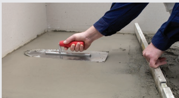
Støbemasse glattes ud med spartel
