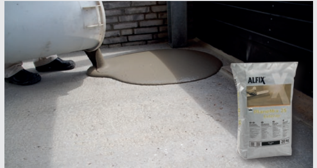
Udhældning af selvudflydende spartelmasse
