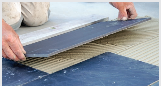
Montering af fliser
