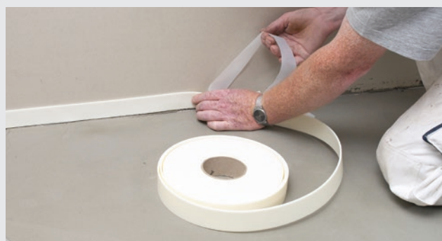
Montering af selvklæbende vægkantbånd
