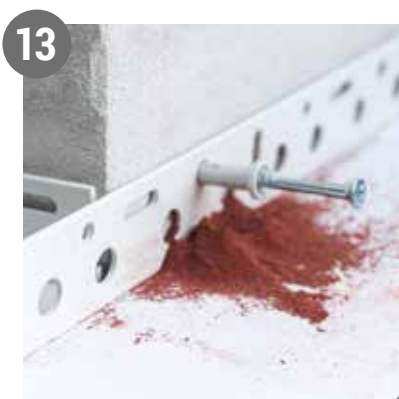
13 Dybelskruen placeres i borehullet.
