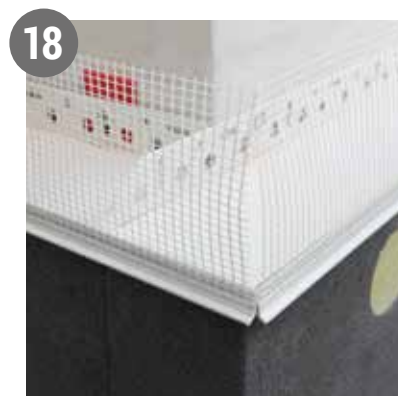
18 Sokkelindstikkene skubbes på plads, så hjørnet bliver helt samlet. Ved samlinger skal sokkelindstikket forskydes min. 10 cm i forhold til sokkelprofilen.
