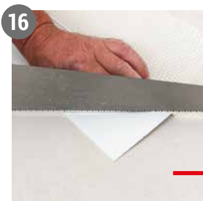
16 Ved hjørner skal sokkelindstikket på begge sider af hjørnet skæres i smig.
