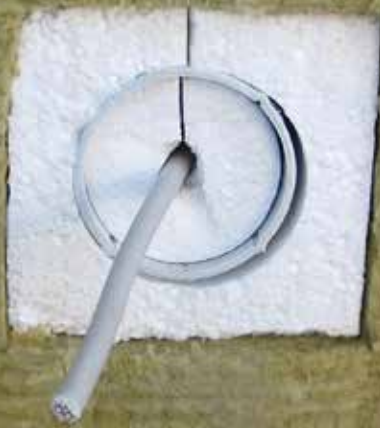
Boxrøret monteres på den faste facade og tilpasses efter isoleringstykkelsen.
