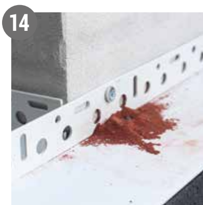
14 Dybelskruen slås ind med en hammer eller skrues fast.
