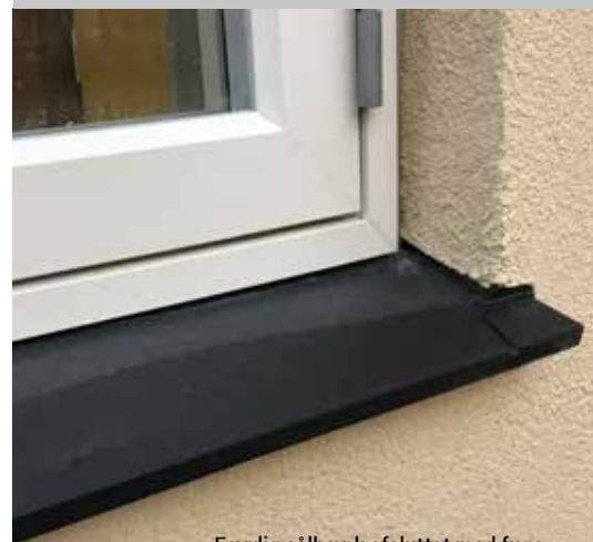
Færdig sålbænk afsluttet med fuge.
