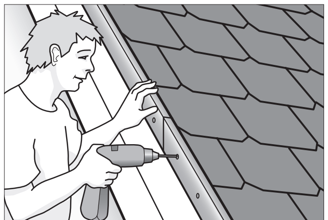
Fastgør løse inddækninger.
