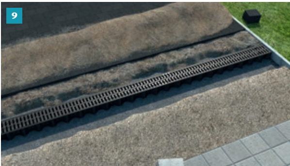
Ved samlet drænlængde på over 5 m, kan elementerne klikkes sammen en ad gangen. Start med udløbselementet.
