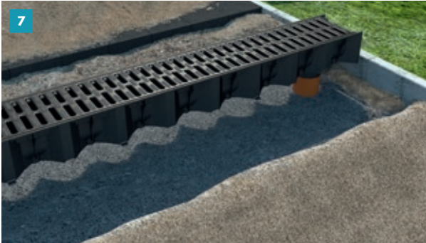
Ved samlet drænlængde på 2-5 m klikkes alle elementer sammen før montering. Kontrollér udløbstilslutning til kloak er korrekt.
