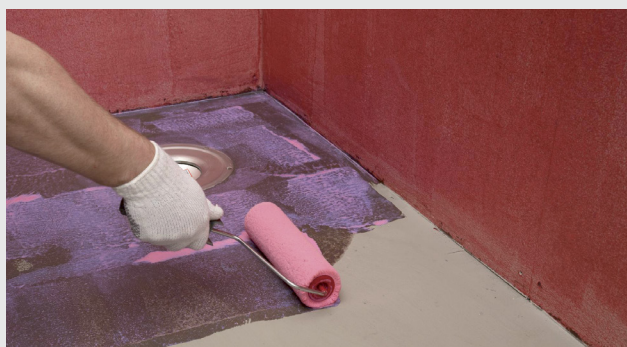
Primning på gulv med rulle
