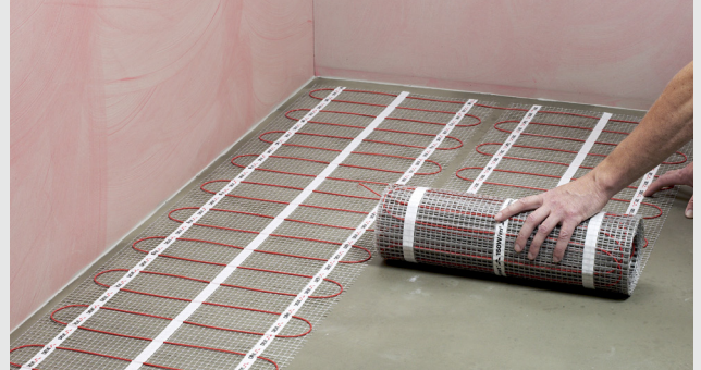
Udlægning af varmemåtter
