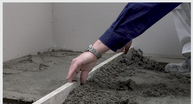
Udstøbning på træbjælkelag
