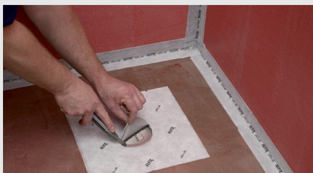
Markering og udskæring af hul
