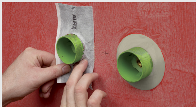
Montering ved rør
