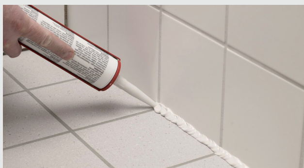
Fyldning med siliconebaseret fugemasse
