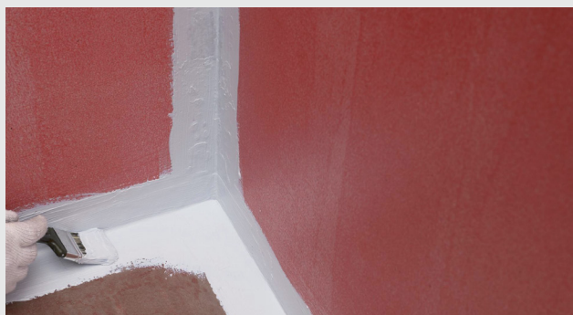
Påføring med pensel
