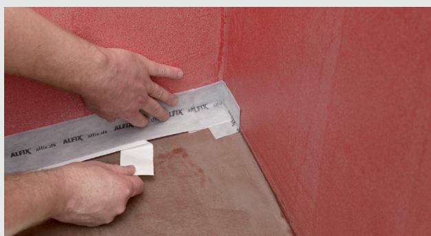
Montering i overgang væg og gulv
