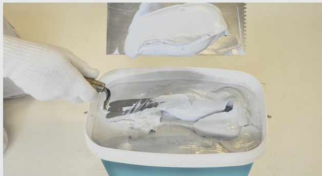
Tætningsmasse klar til påføring
