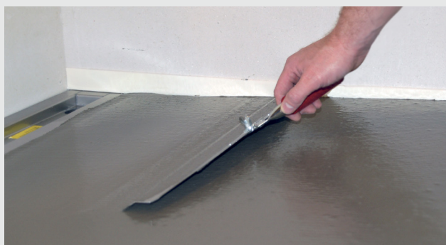
Faldopbygning ved vægnært gulv afløb
