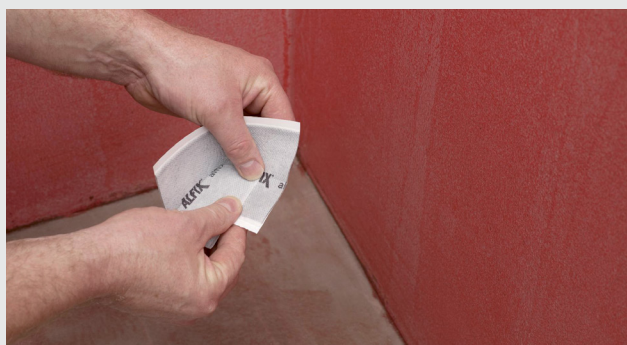
Tilpasning af selvklæbende hjørne
