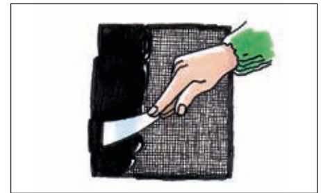
Der påføres to lag Tagkit. I det første, våde lag lægges et stykke væv, hvorefter sidste lag påføres.
