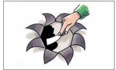
Underlaget skal være helt tørt, før der påføres Icopal Tagkit.
