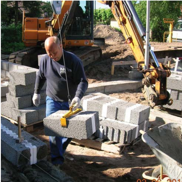
Blok placeres nemt med blokløfter monteret på rende-graver eller andet stabilt grundlag.
