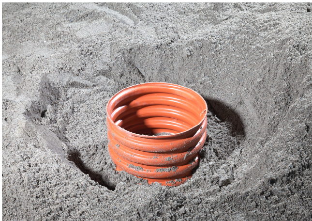
Ø315 PVC opføringsrør
