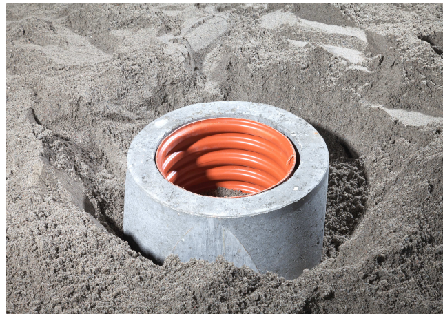
Beton kegle sættes ned over opføringsrøret.
