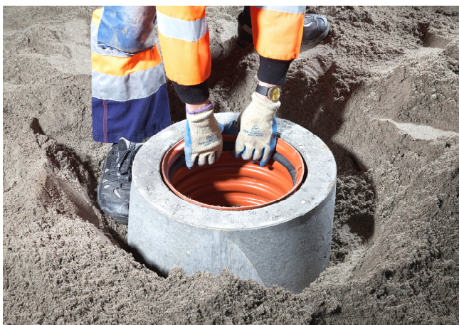
Cellegummiringen monteres i opføringsrøret.
