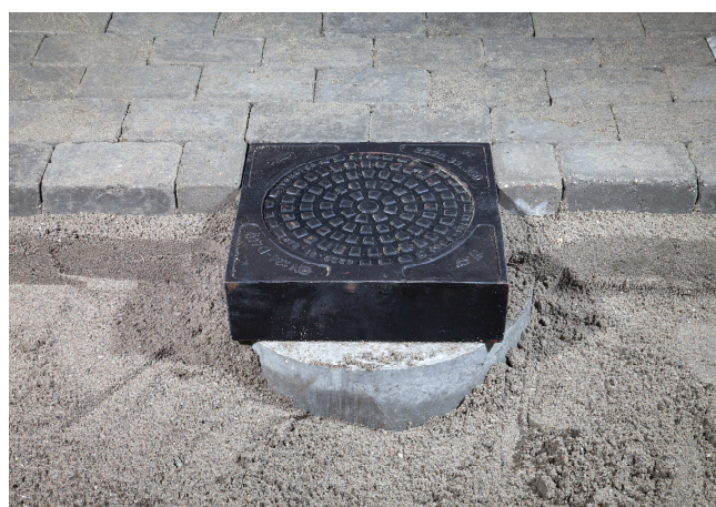
Gruset stemples og rettes af. Belægningsstenene skæres til og lægges. Et plant og flot resultat.
