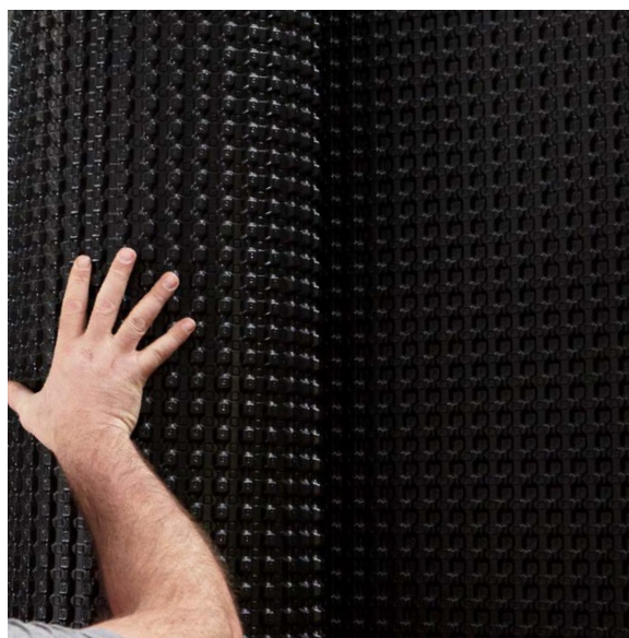
Montering af Platon Xtra Grundmur
