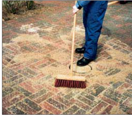
Ved brønddæksler og lignende opstår der ofte lunker pga. for dårlig komprimering eller manglende overhøjde ved lægningen. Oprettningen udføres dog let.
