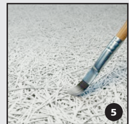
Mal over med reparationsmaling i samme farve som pladen
