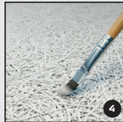
Mal over med reparationsmaling i samme farve som pladen
