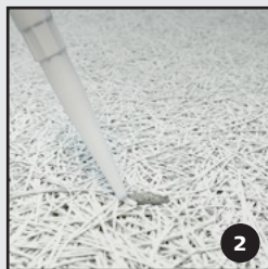
Påfør fugemasse
