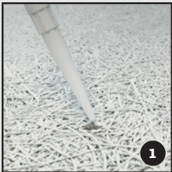
Påfør fugemasse
