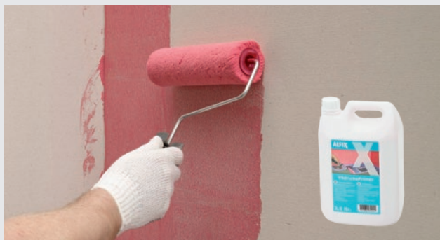
Primning på væg med rulle, VådrumsPrimer
