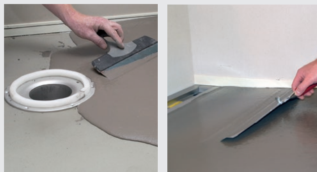
Opbygning af fald med spartelmasse, PlaneMix 60
