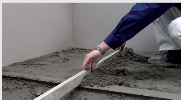
Afretning af overflade
