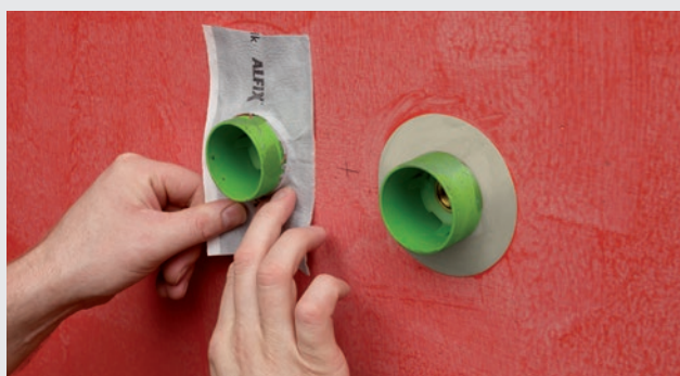
Montering ved rør
