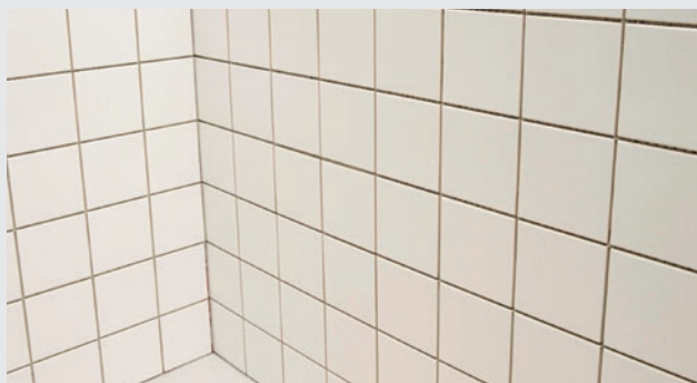
Klar til fugning
