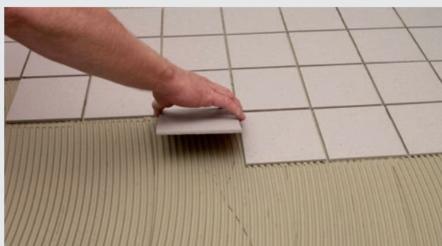
Montering på gulv
