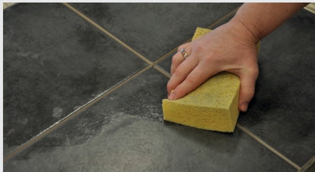
Overfladen fugtes
