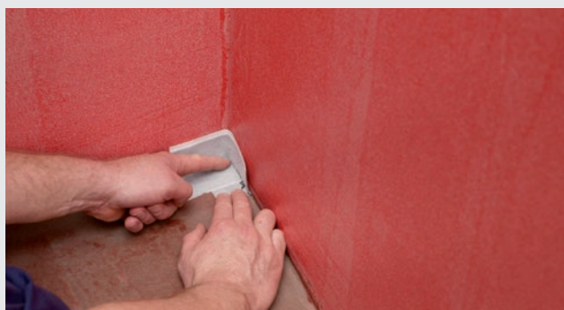
Montering af Seal-Strip i hjørne
