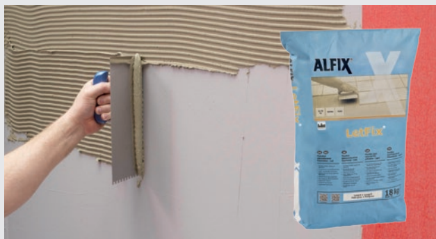
Påføring af fliseklæber, LetFix
