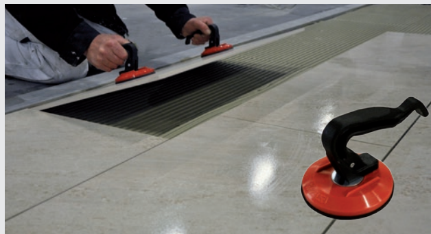
Lægning af fliser ved hjælp af sugekop
