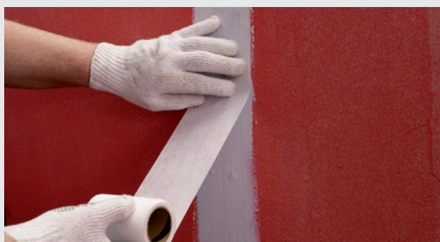
Forstærkning af samling med armeringsvæv
