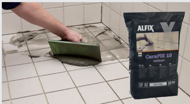
Påføring af cementbaseret fugemasse på gulv, f.eks. CeraFill 10 colour
