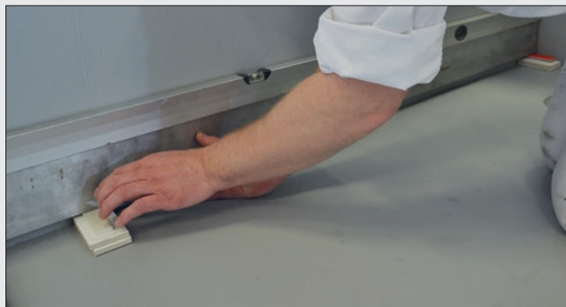
Markering af vandret linie med retskinne
