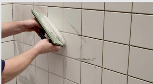
Påføring af cementbaseret fugemasse på væg
