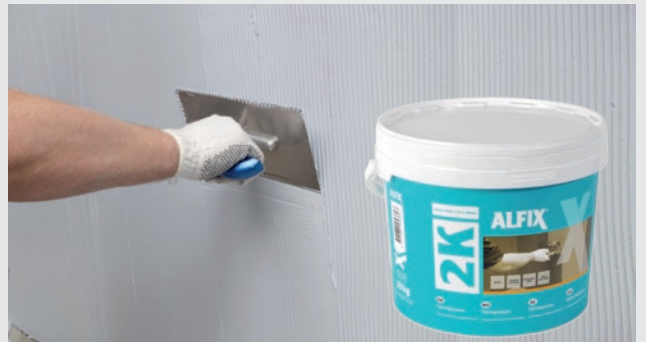
Påføring med tandspartel, 2K Tætningsmasse
