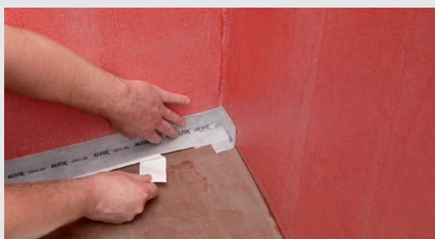
Montering af Seal-Strip i overgang væg og gulv
