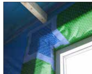
Ved lette skelletvægge klæbes lysningsfolien til dampspærren. Det er vigtigt at sikre, at der er fast underlag i samlingen. I lysningens hjørner monteres DAFA hjørne blå, som forsegles med DAFA tape blå
