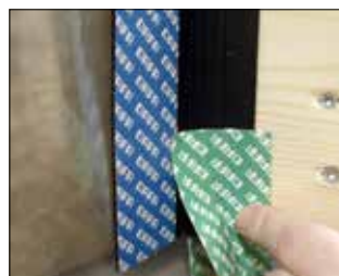
DAFA spærfodskrave forsegles på den åbne side med DAFAs grøn dampspærretape
