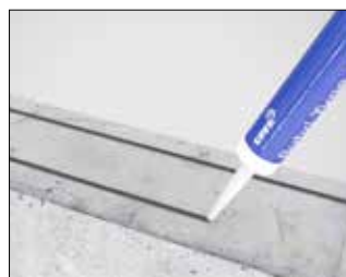
Der udlægges 2 striber butylfuge inden folien udrulles
