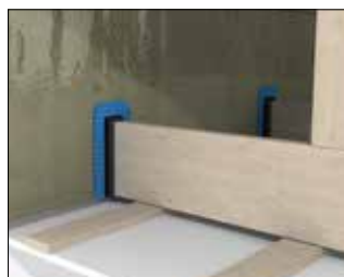
DAFA spærfodskrave monteret til etagebjælke
