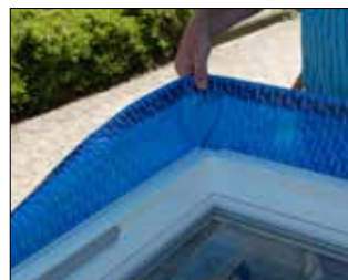
Folien monteres til karmen, inden vinduet monteres. Alle hjørner udføres med en fold på 1-2 cm for at folien kan nå ud til hjørnet af lysningen
