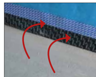
Det er vigtigt, at sokkel- og remfolien altid klæbes opad fast underlag
