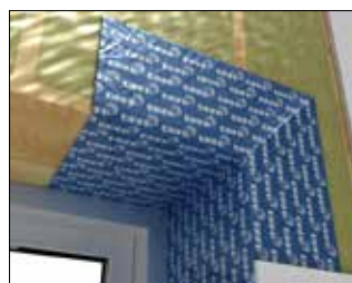
DAFA udvendigt hjørne, monteret i vindueslysning
