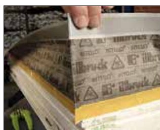
Folien monteres til karmen inden vinduet monteres. Alle hjørner udføres med en fold på 1-2 cm, for at folien kan nå ud til hjørnet af lysningen.
