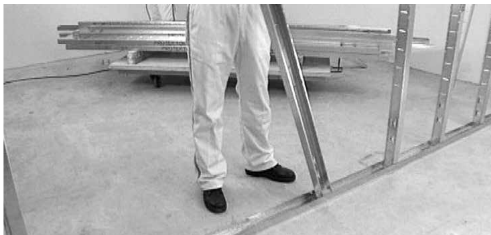
Montage af CW-stålprofiler.
