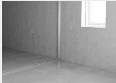
Montage af stålprofiler i top- og bundskinne af stål.
