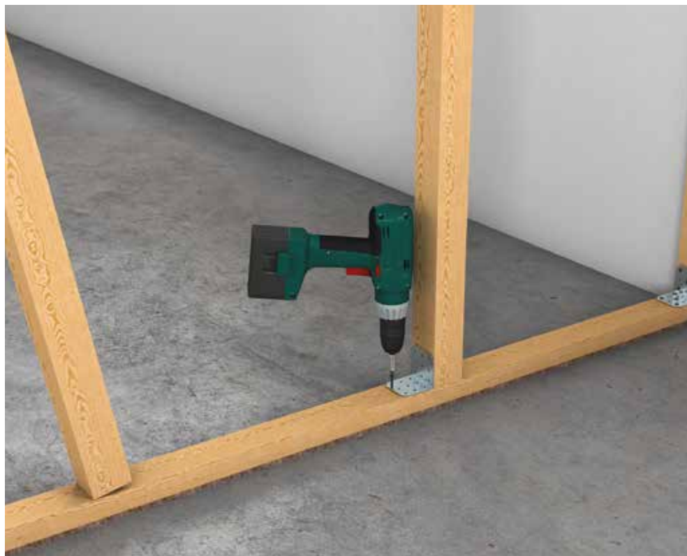
Montage af underkonstruktion i træ.
