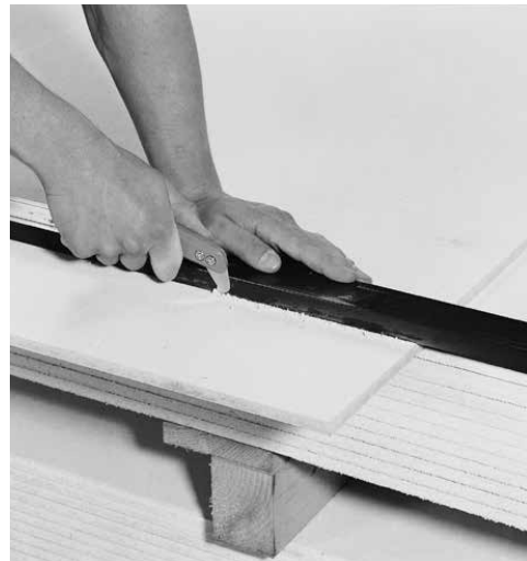
Step 1 - Ridsning og knækning.
