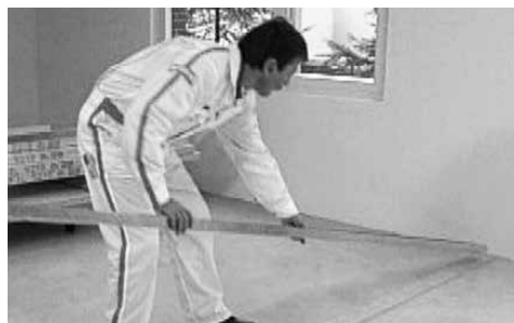
Læg C-profilet/skinen på gulvet
