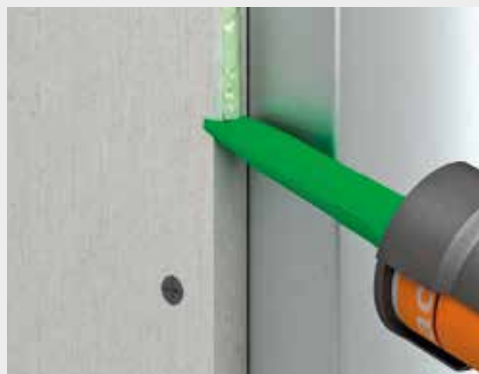
Klæbefuge påføres i midten af pladekanten.
