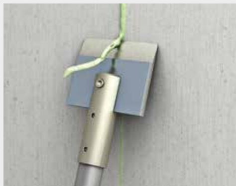
Fjern overskydende klæbefuge efter cirka 24 timer.
