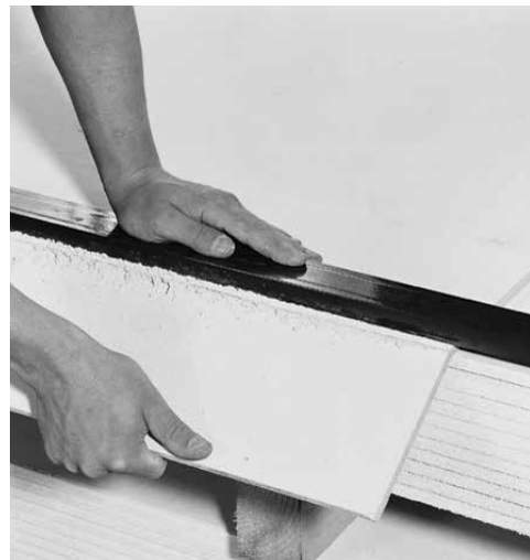
Step 2 - Ridsning og knækning.
