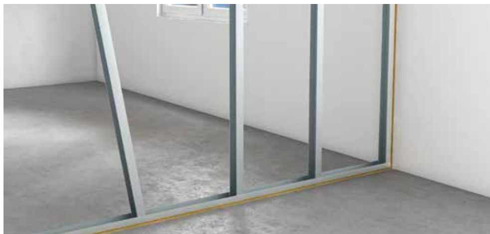
Montage af CW-stålprofiler.
