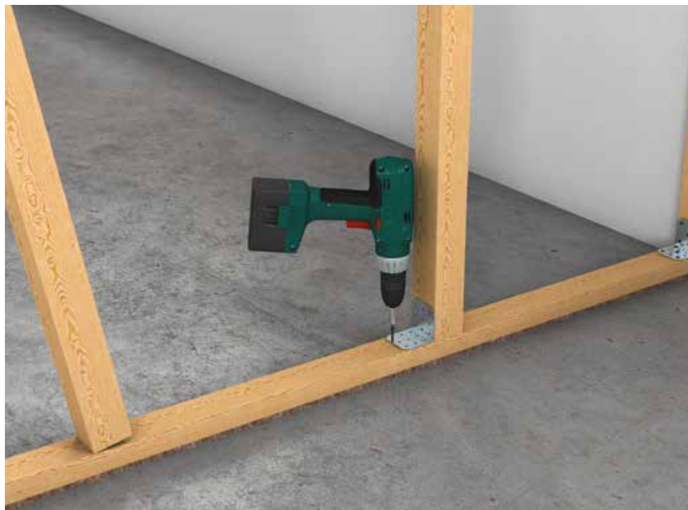
Montage af underkonstruktion i træ.
