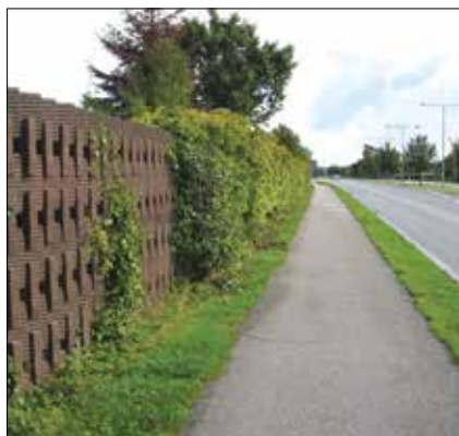
Støjmur. Muren er lavet åben for at kunne beplante den og for at reducere den støj der reflekteres til den anden side af vejen.
