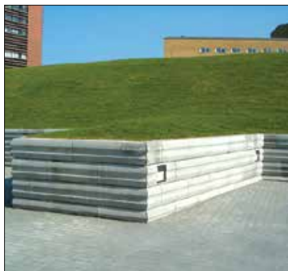
Støttemur. Det er vigtigt ved dimensioneringen at tage højde for belastningen oven for muren, f.eks. trafik eller som her jordvolden.
