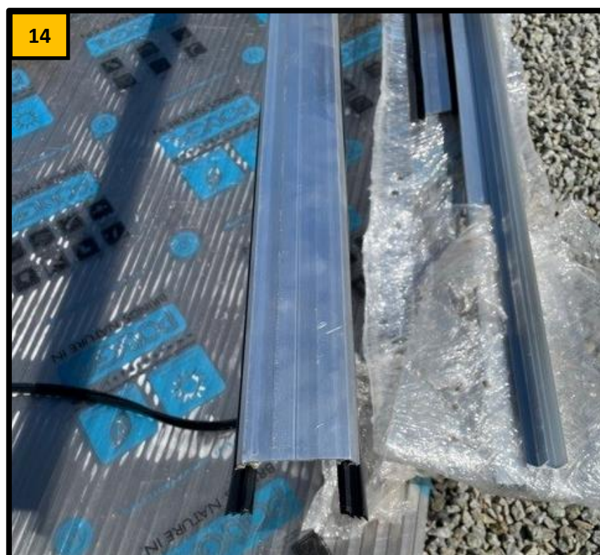
14. Montering af gummibånd i Top aluprofiler. Gummibånd trykkes i notgang på begge sider af aluprofilerne.
